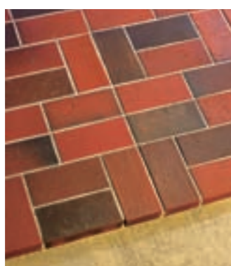
Wiązanie blokowe w połączeniu z prostoliniowym. Te i podobne układy sprawdzają się przy mniejszych obciążeniach, na przykład na tarasach.
