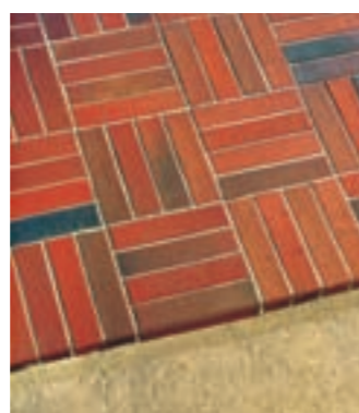
Na przemian po cztery wąskie klinkierowe cegły brukowe ułożone w przeciwnych kierunkach.
