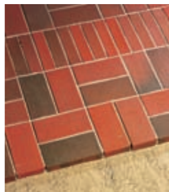
Wiązanie blokowe z pasmem ozdobnym z wąskich cegieł
