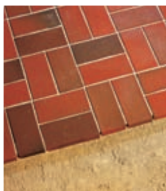
Na przemian po dwie klinkierowe cegły brukowe ułożone w przeciwnych kierunkach
