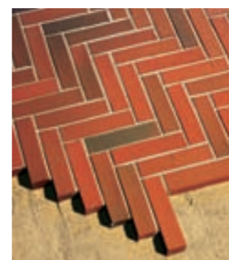
Wiązanie w jodełkę z wąskich klinkierowych cegieł brukowych
